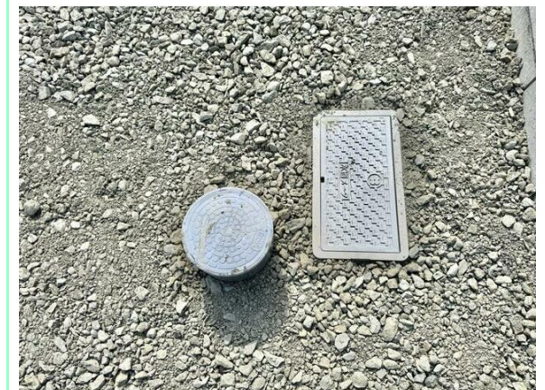
上下水道引込工事済みです☆
