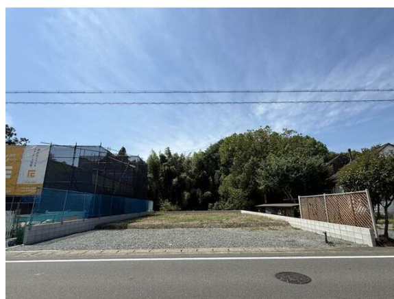
造成工事・上下水道引込工事完了済み☆
