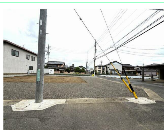
造成工事完了済！上下水道引込工事後にお引渡し！
