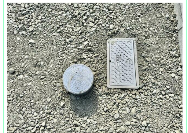
上下水道引込工事済みです☆
