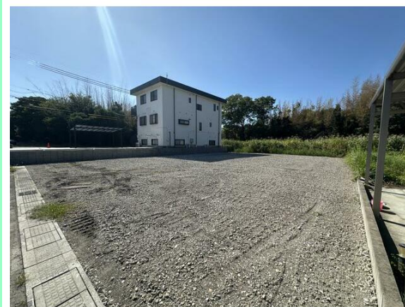
造成工事完了済みです☆
