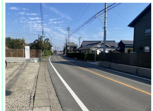
前面道路状況
